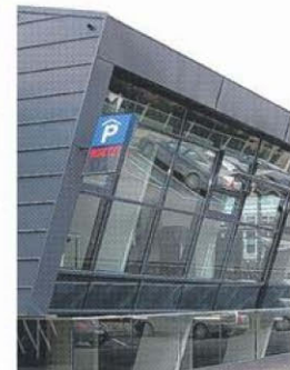
60 neue Parkplätze im Untergeschöß
